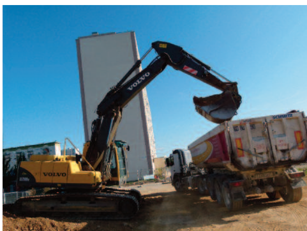
Premier coup de pelle pour les fondations du Cèdre
