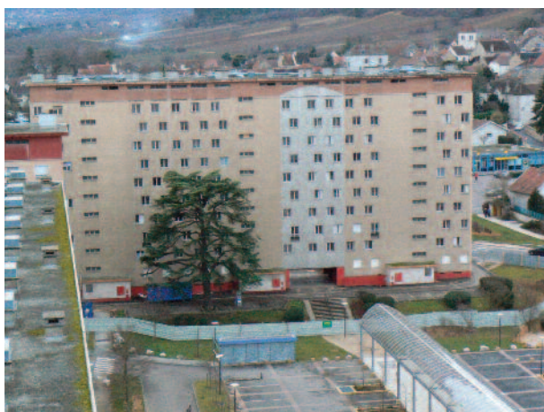
Le bâtiment Charcot avant sa déconstruction
