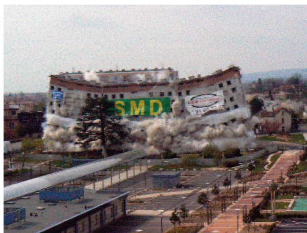
Implosion du bâtiment Charcot
